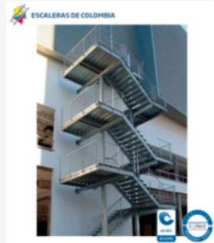
Escalera Tipo Estructura
